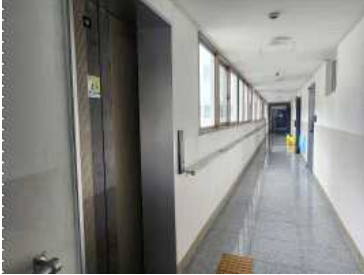
문턱이 없는 미닫이 화장실 출입문
